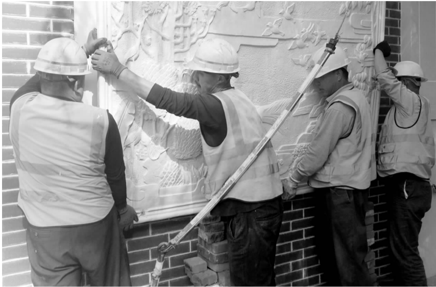
4名施工人员合力将浮雕安装在墙体上
