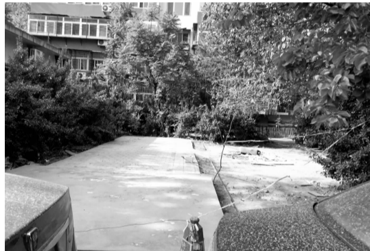
黄木庄3号院休闲亭翻建地面重新铺装
