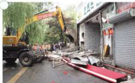
拆除占压燃气管线
