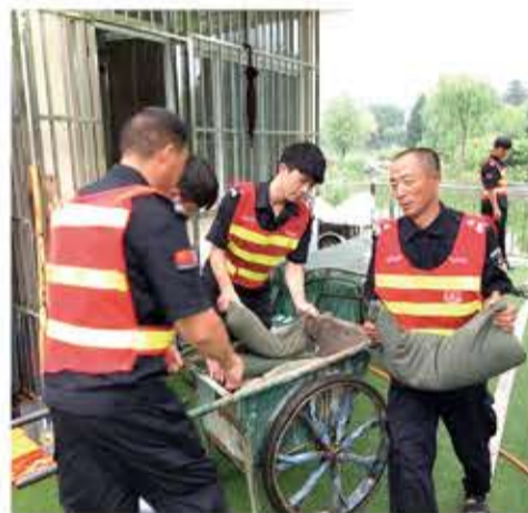
▲工作人员运送沙袋筑起“挡水墙”
