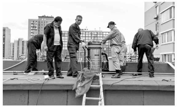
工作人员现场进行抽水作业
