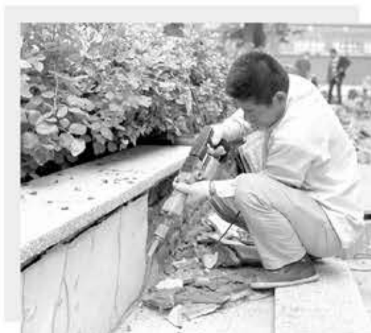
施工人员对原有花坛进行拆除
