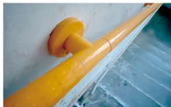
老楼安上黄色新扶手
