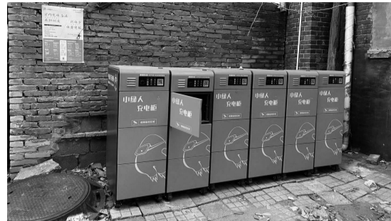
安装的充电桩也能充当储物柜
