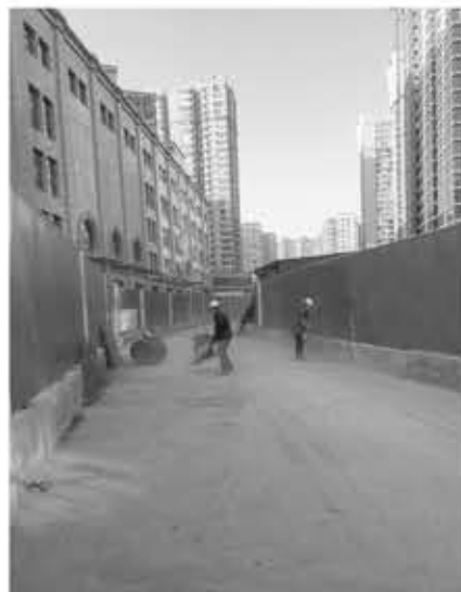
清理后的路面可供居民通行
