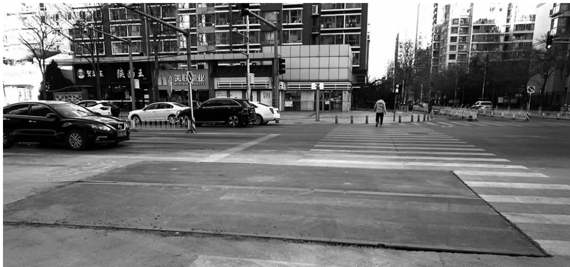
管线检修后,工作人员对路面进行了及时修补。
