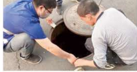
双井街道“接诉即办”修理井盖
