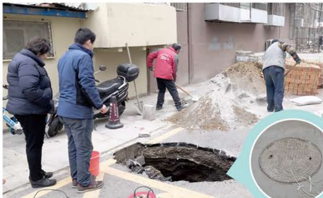
▲工人对塌方路面进行抢修
