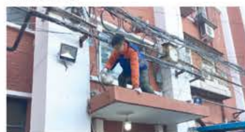
社工“登”上高处检修。
