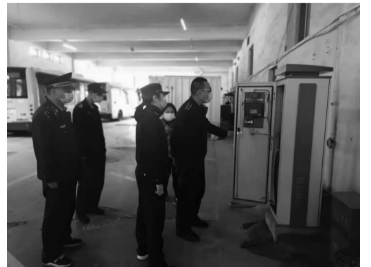
街道工作人员检查大型储电装置
