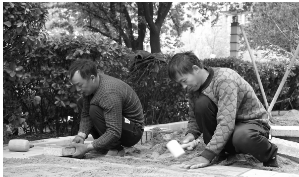
工人对路面进行维修
