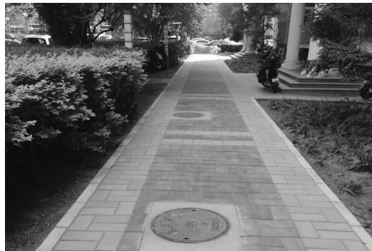
维修后的路面恢复平整
