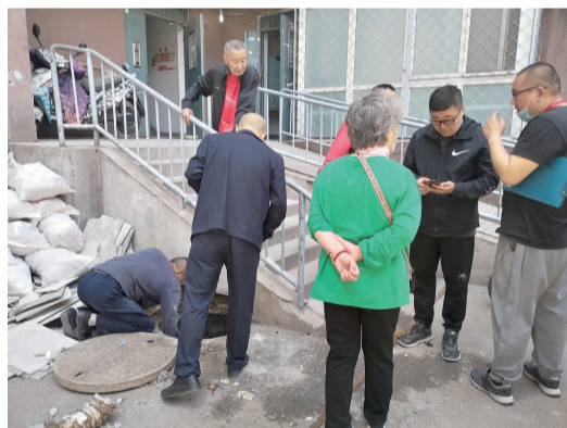
社工及工作人员在现场协调疏通管线
