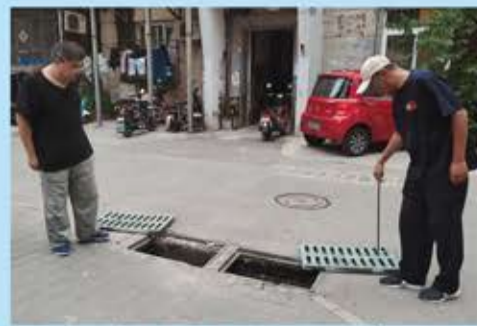
▲工作人员检查雨篦子排水能力,清理污泥。
