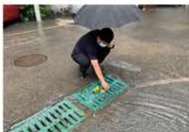
社区工作人员雨中用手清掏雨篦子
