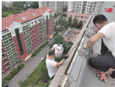
工人对楼体外墙进行维修
