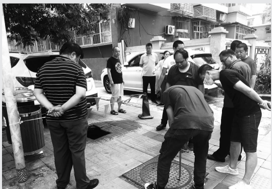
工作人员现场对漏水管线进行检查
