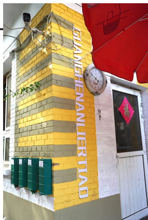
粉刷后的警卫室焕然一新
