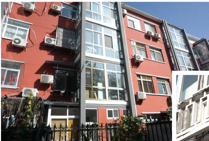
◀ 阳台修整,小区变身阳光房。
