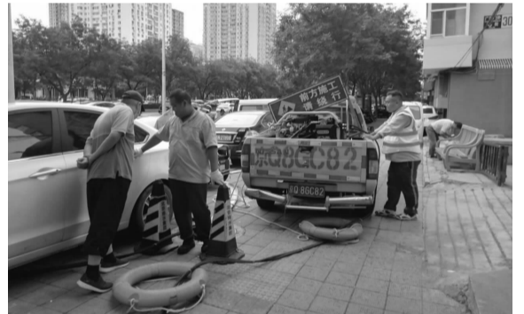
工作人员勘探下水管主管道
